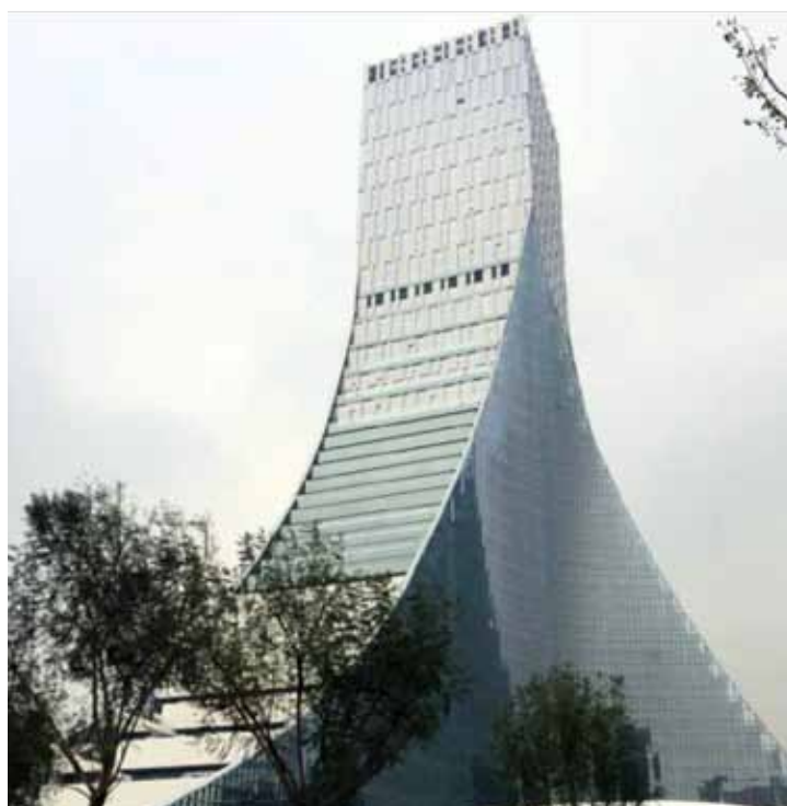
L'immeuble de La « soft landing platform de sophia antipolis à chengdu . 2000 m 2 inauguré en Mai 2017
