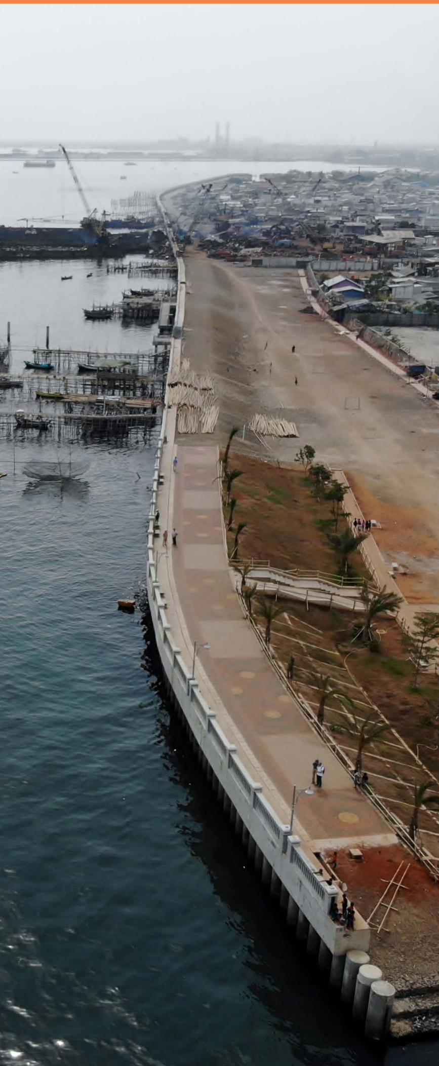
Lente progression de la construction du mur littoral
